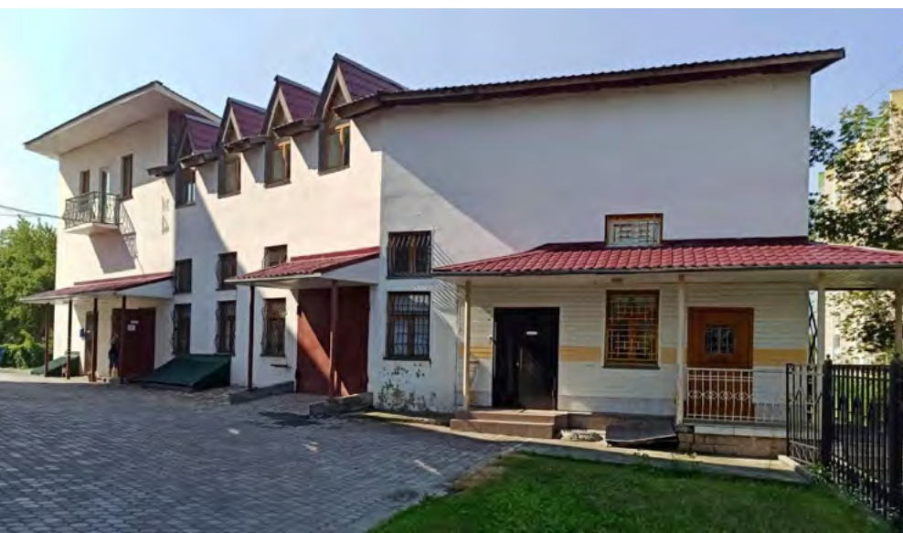
Das Gebäude der Regionalcaritas Tscheljabinsk. Im linken Gebäudeteil befinden sich das Mutter-Kind-Zentrum, rechts der Kinderclub. Das gesamte Haus darf nun nicht mehr genutzt werden.
